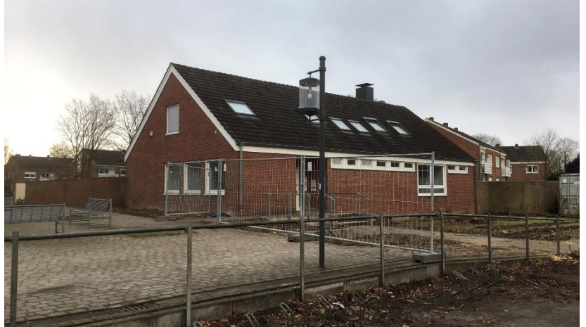
Unser Pfarrhaus vor dem Abriss – Verzicht und Neuaufbau
